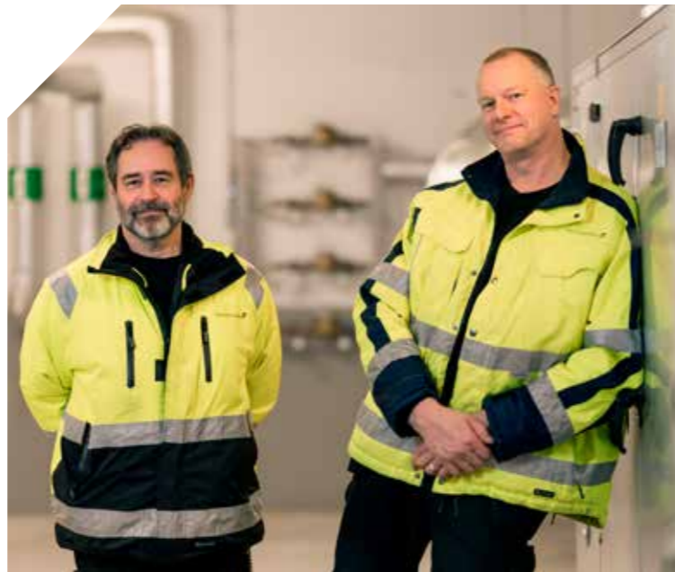
Vakar över värmen. Finnvedsbostäders driftstekniker Mats Andersson (t v) och Peo Schliemann kontrollerar att vår värme och ventilation fungerar som den ska.
